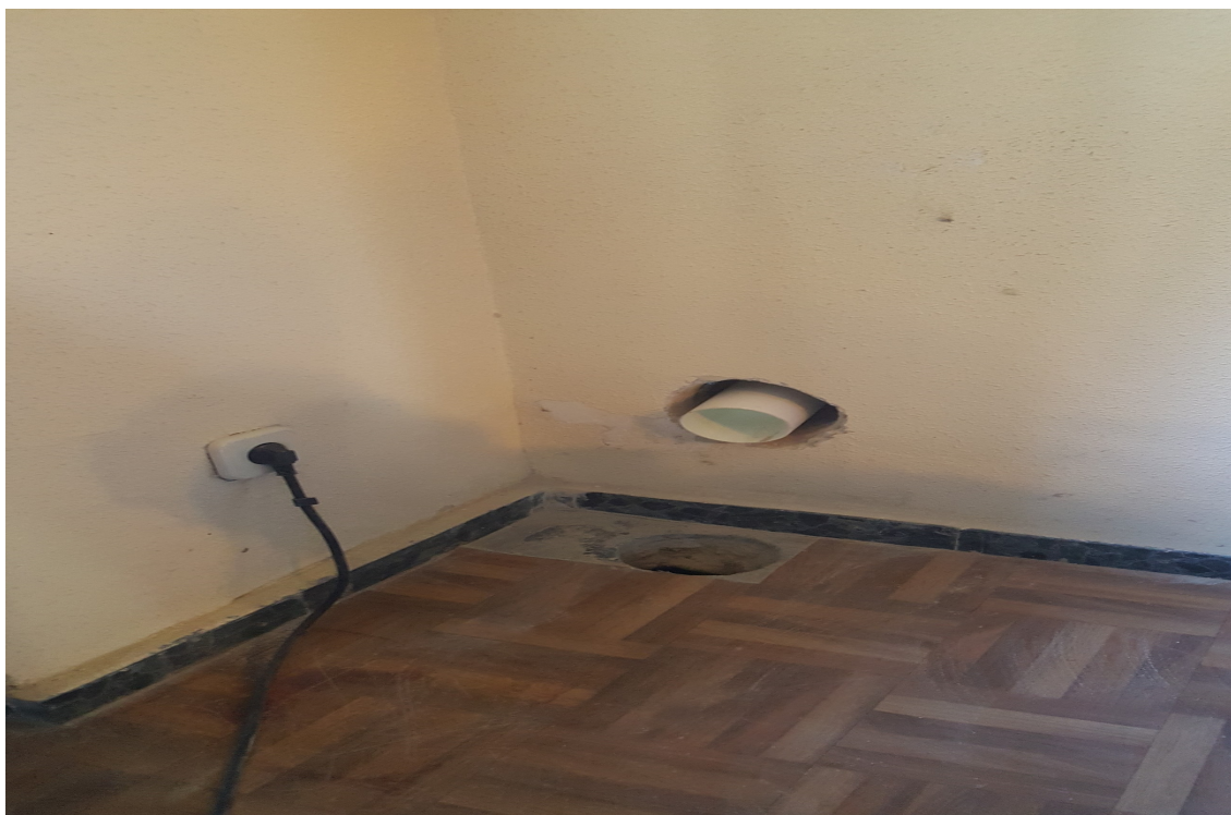
Figura 14. Ejecución del punto de extracción del sistema de actuación.
