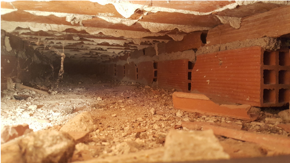
Figura 7. Cámara sanitario localizada bajo parte de la vivienda.
