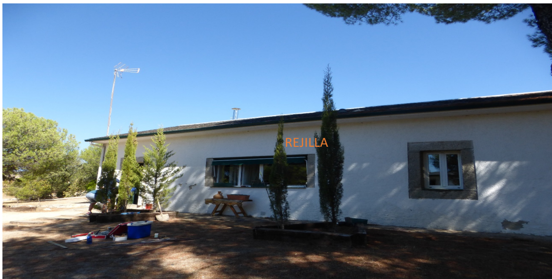
Figura 6. Rejilla de ventilación en la fachada principal de la vivienda.
