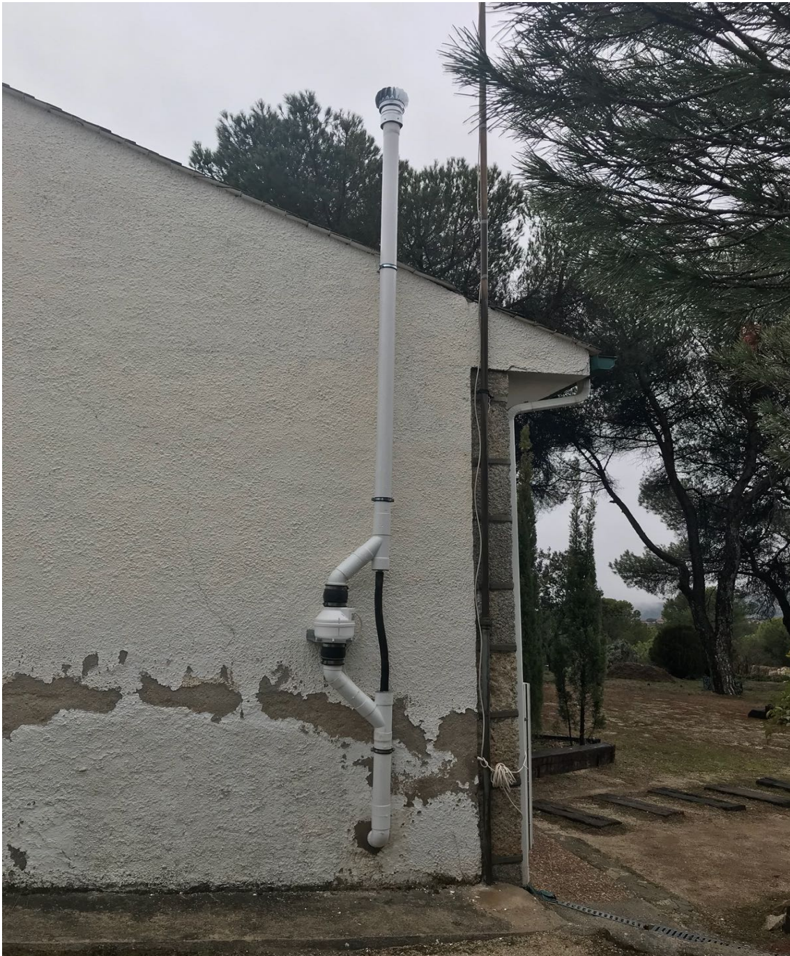
Figura 15. Instalación del sombrero eólico tras la semana de medición de concentración de radón de referencia.
