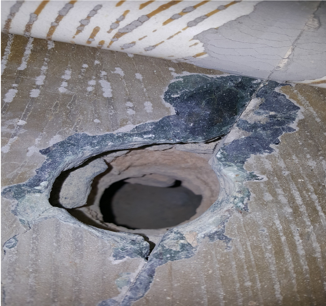
Figura 9. Ejecución del taladro correspondiente a la extracción número 1.
